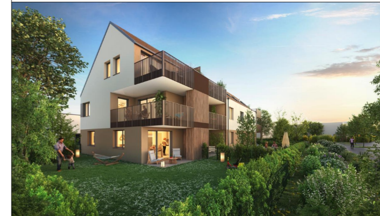
BÂTIMENT B / N° 109 / T3 / Combles
